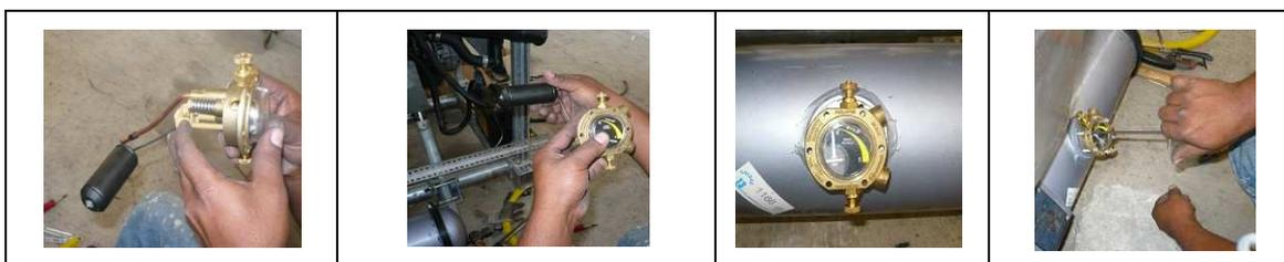
**Figura 3.16** Instalación de la multiválvula en el tanque de almacenamiento GLP.
