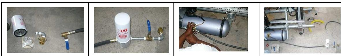
**Figura 3.17** Proceso de instalación del sistema de carga de GLP.
