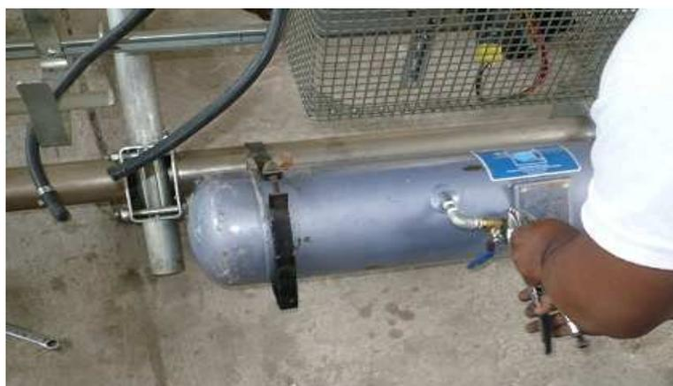
**Figura 3.18** Proceso de instalación del sistema de desfogue de GLP en el tanque de almacenamiento de GLP.
